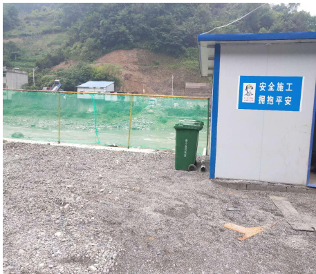
生活垃圾暂存间
